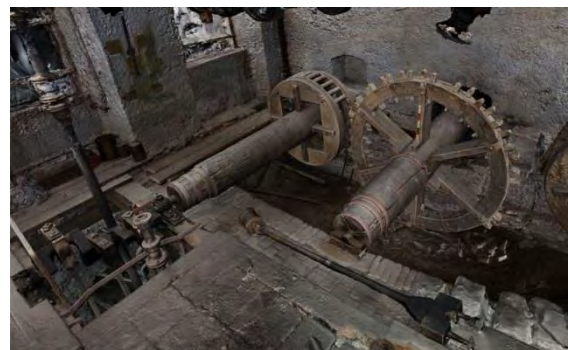
Abb. 4 Screenshot des 3D-Foto-Modells: Pumpenraum des Schwetzingen Wasserwerks
